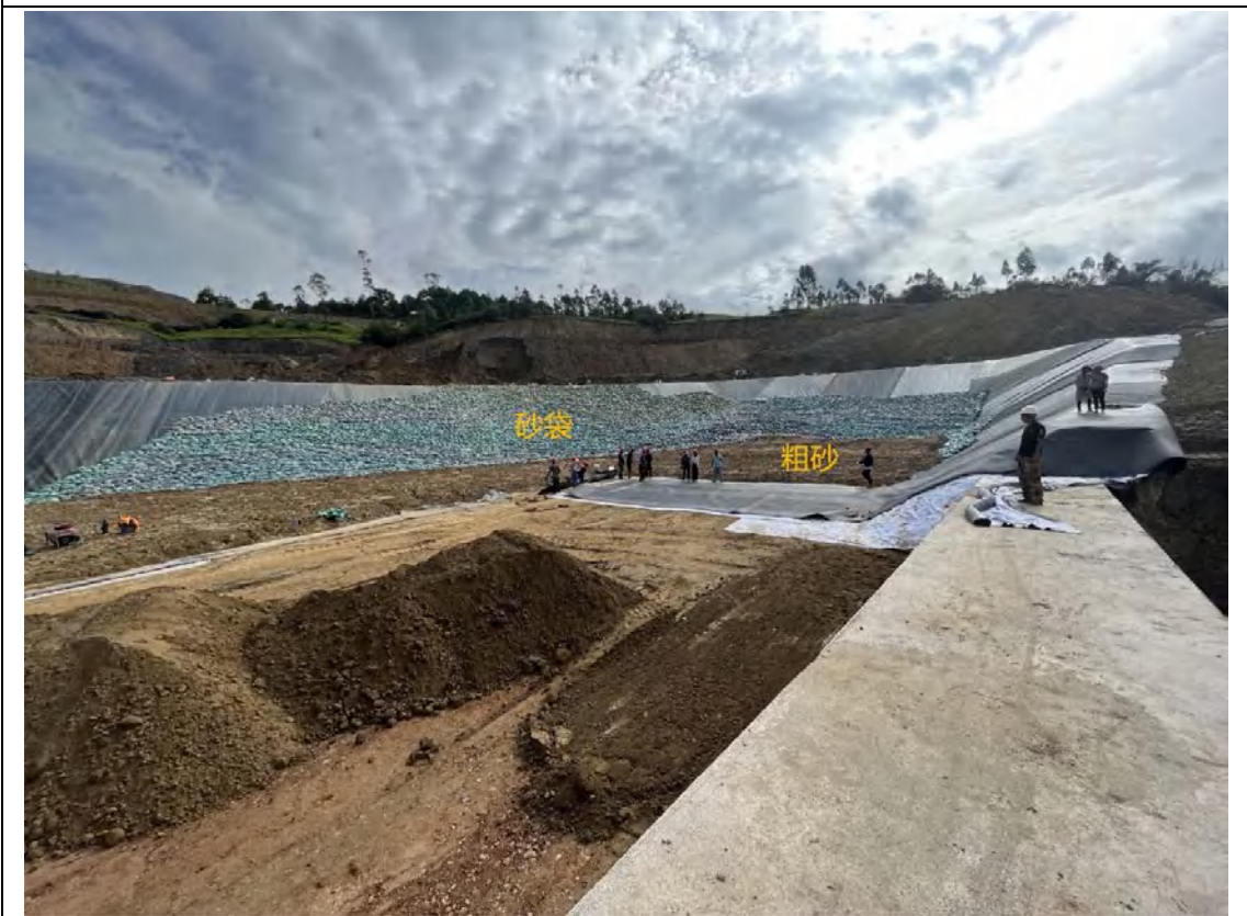
堆浸场防渗施工
