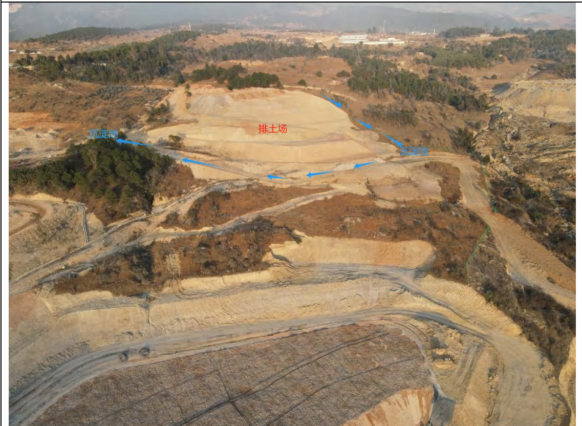
排土场周边截洪沟及沉淀池
