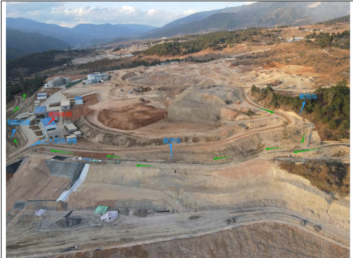
堆浸场堆浸场北侧截洪沟及现有沟渠
