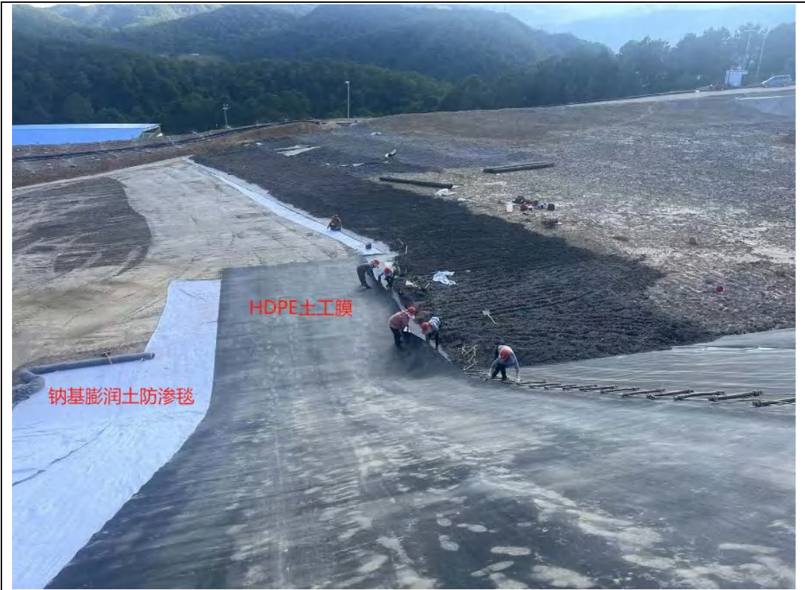
堆浸场防渗施工
