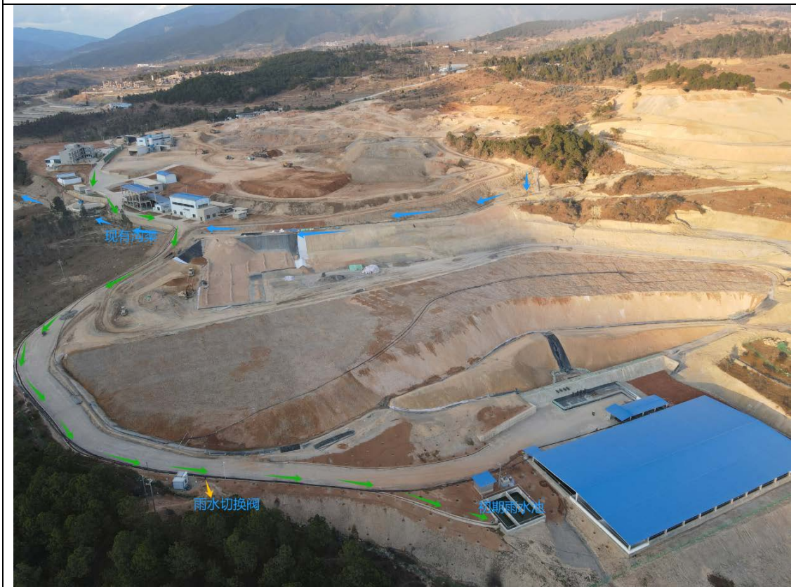
堆浸场西侧沿厂区道路截洪沟及雨水切换阀
