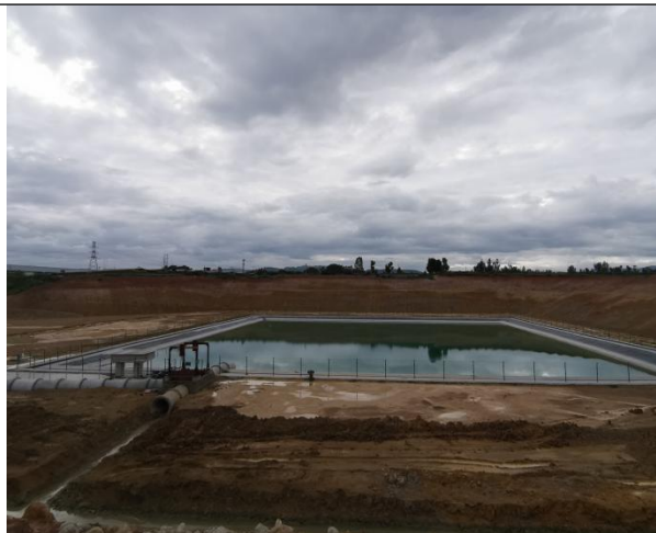
初期雨水收集池
